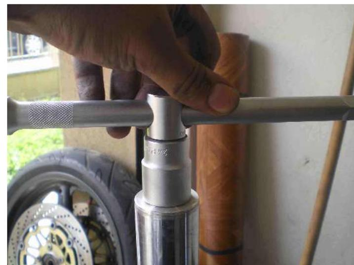
Con l'aiuto di una bussola da XX e facendo una leggera pressione per contrastare la spinta della molla interna, svitiamo il tappo. A differenza di quanto si possa credere non è molto duro da aprire...
